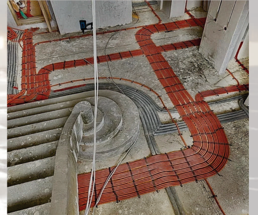
Mənzillərin kabelləşməsi
